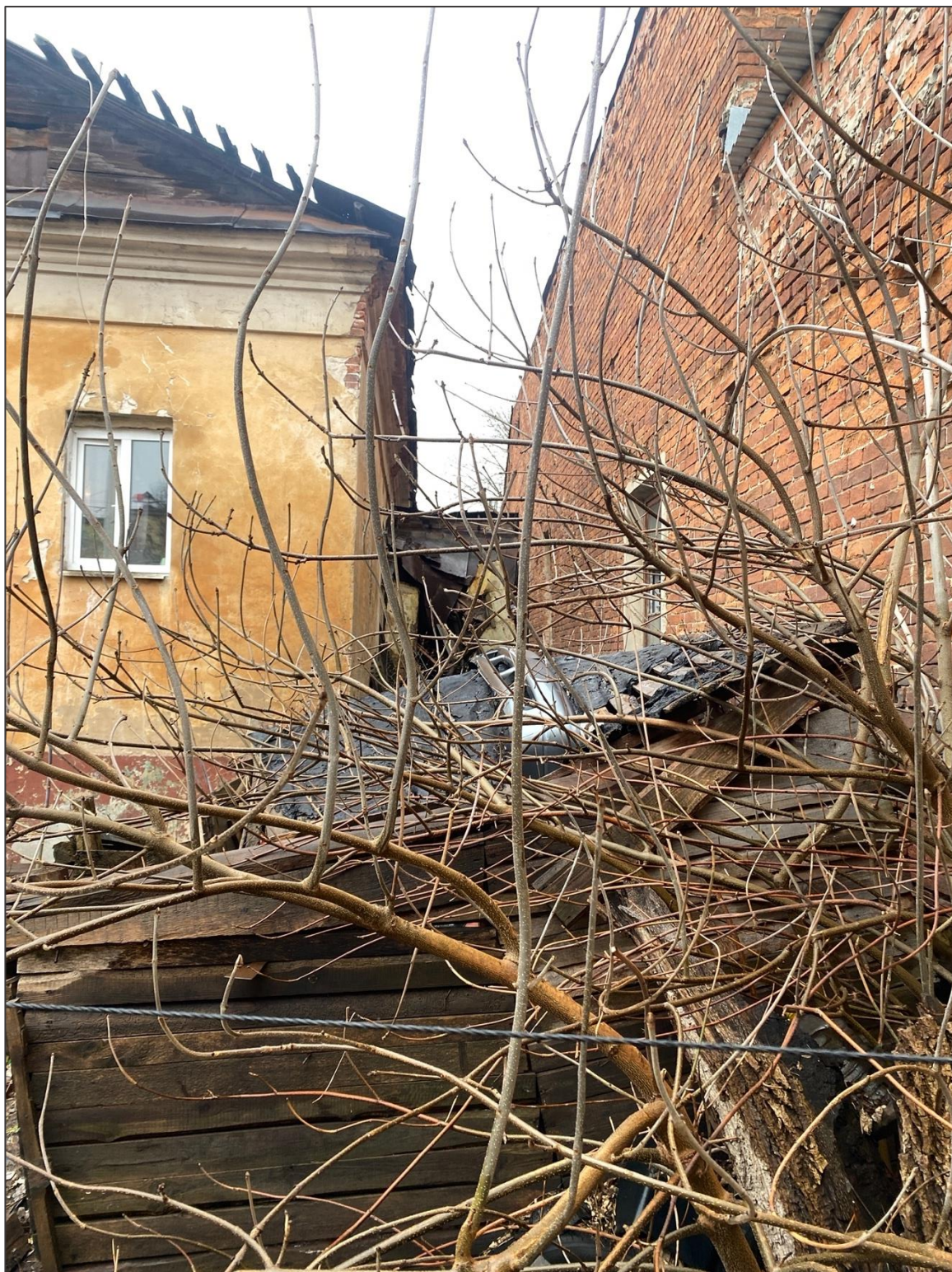
Т.ф. 5. Памятник. Дворовой фасад. Состояние деревянного тамбура (см. план БТИ 1944 и 1970 гг.). Состояние территории. Дата 11.04.2022. Автор А.Ф. Мартынов
