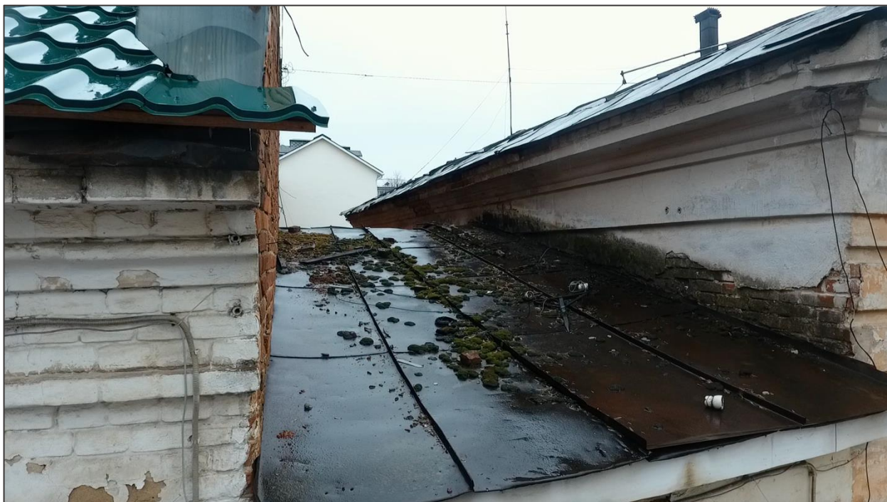
Рис. 9: Примыкание через каменную одноэтажную вставку к кирпичному одноэтажному зданию исторической застройки. Фрагмент. Дата 11.04.2022. Автор А.Ф. Мартынов
