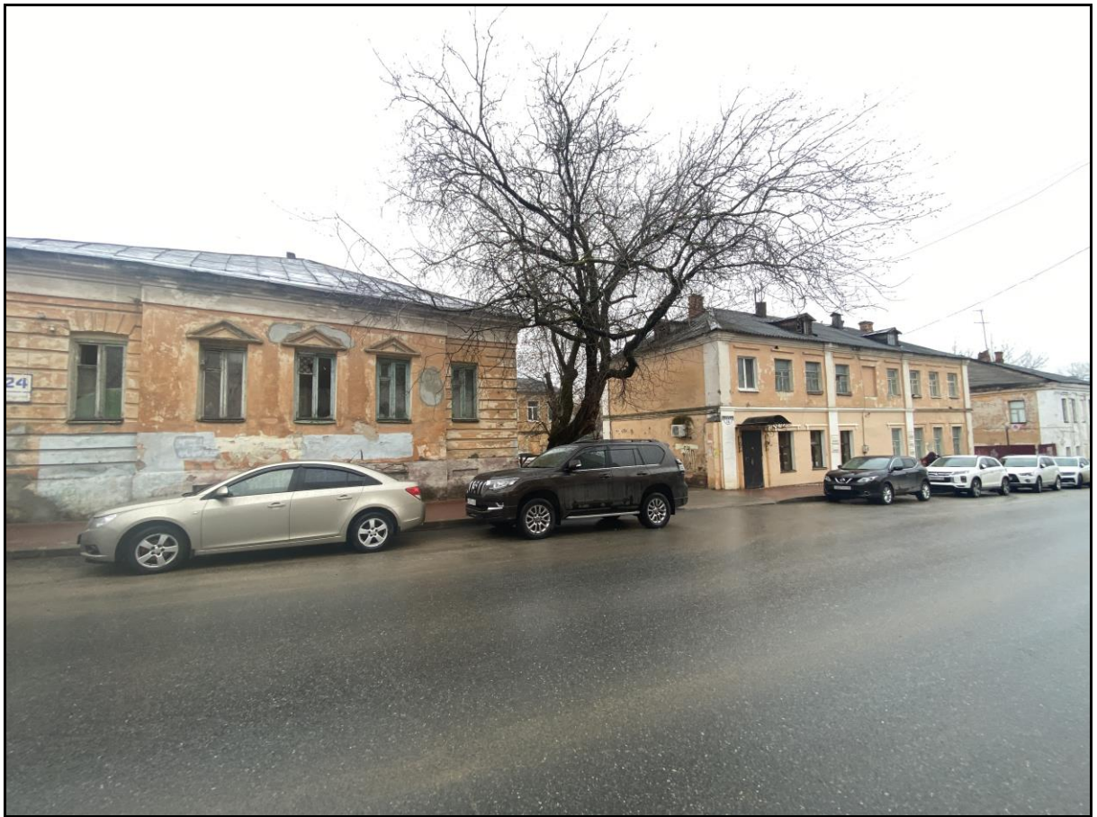
Т.ф. 1. Памятник. Главный фасад. Фрагмент застройки. Проезд между домами 24 и 26. Дата 11.04.2022. Автор А.Ф. Мартынов
